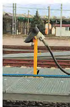
Figure 3: Bornes de préchauffage
