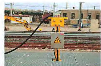
Figure 3: Bornes de préchauffage
