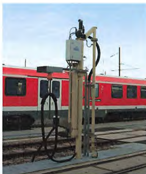
Figure 7: Station de ravitaillement en sable
