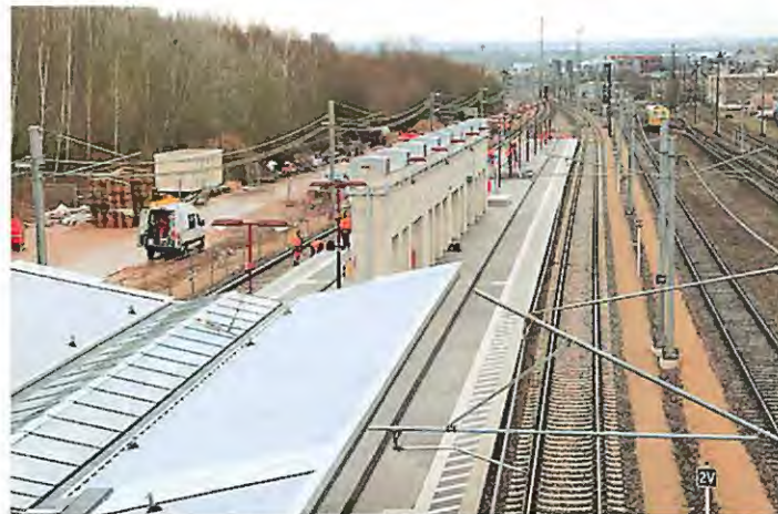
Piliers de la future plateforme d'échange
