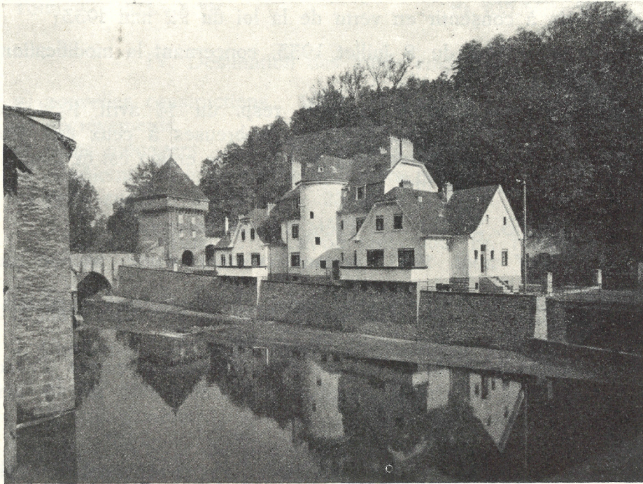
PFAPPENTHAL - Rue St Mathieu (Nouvel état)
